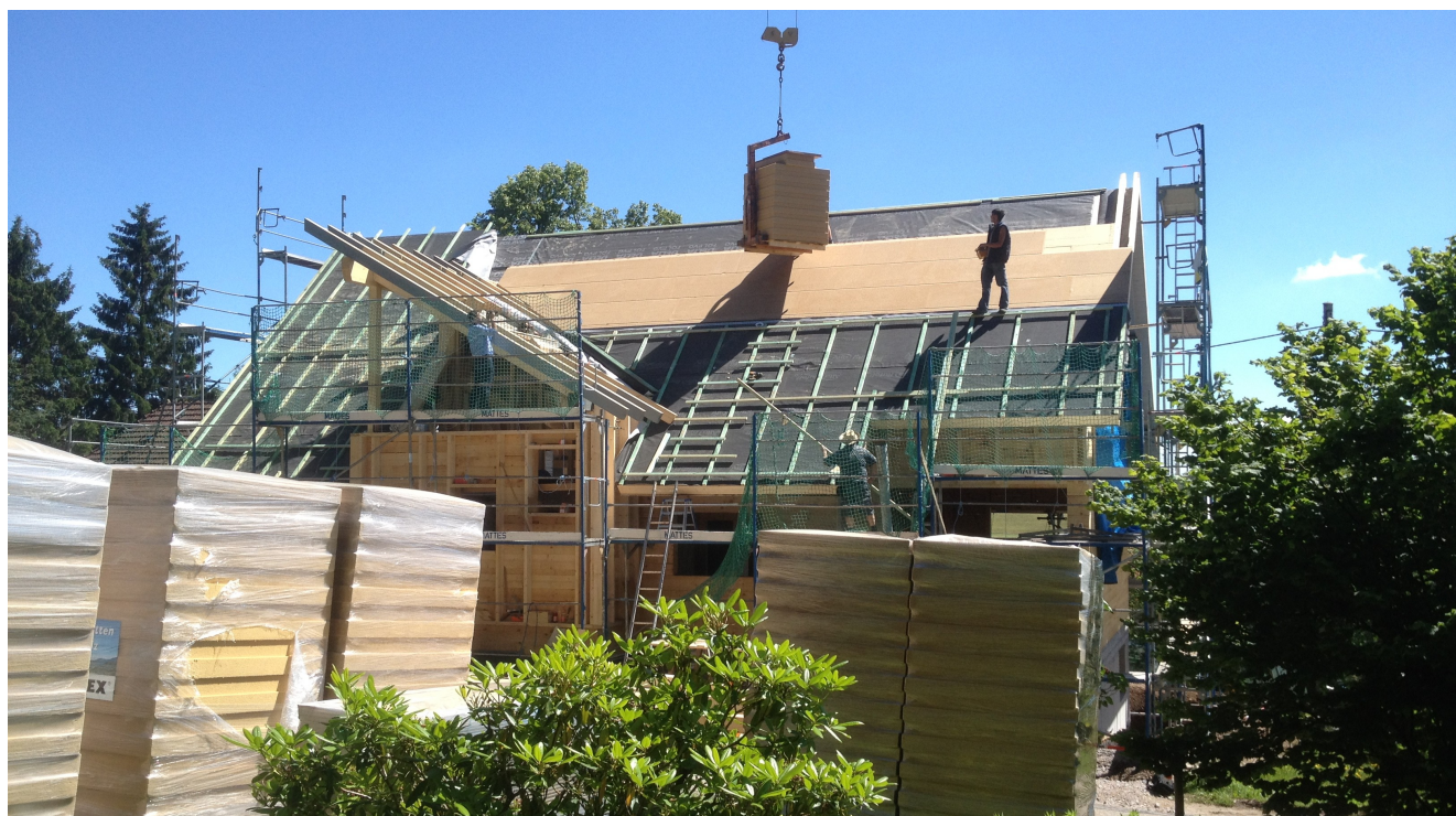
Abb 1. Holzneubau mit Dämmpaket auf Passivhausniveau: GUTEX Holzfaserdämmung in Dach- und Wandaufbau. (Quelle: Architekturbüro Lauber)
