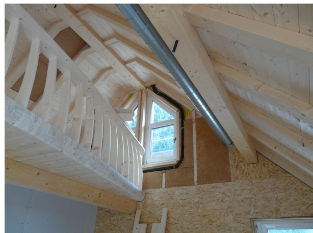
Abb 3. Ansicht zur Holz-Galerie, Dämmung der Installationsebene mit GUTEX Thermoflex Holzfaserdämmung. (Quelle: GUTEX)
