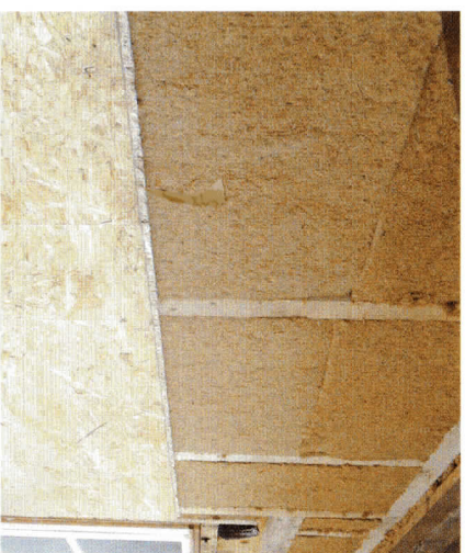
Die flexiblen „Thermoflex“-Dämmplatten lassen sich einfach in die Gefache einklemmen.
