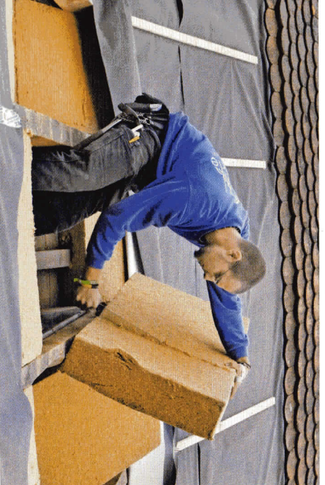
... Formen und Größen anpassen lassen, wie mit dem handlichen „Thermoflex“-Messer.
