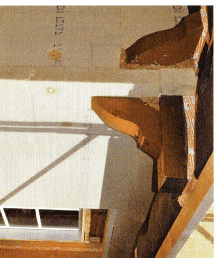
Auch die Fensteranschlüsse und -laibungen müssen fachgerecht überdämmt werden.
