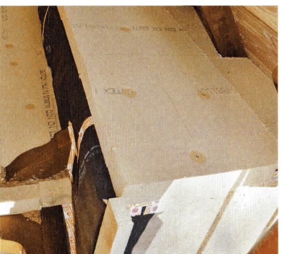
Die feuchteunempfindlichen „Multitherm“-Platten eignen sich bestens für hinterlüftete Fassaden.
