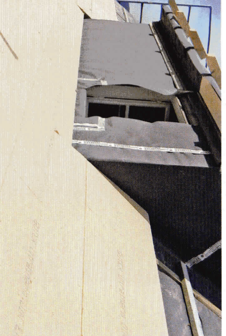
Die regendichten „Ultratherm“-Platten mit Nut und Federn bilden ein regensicheres Unterdach.
